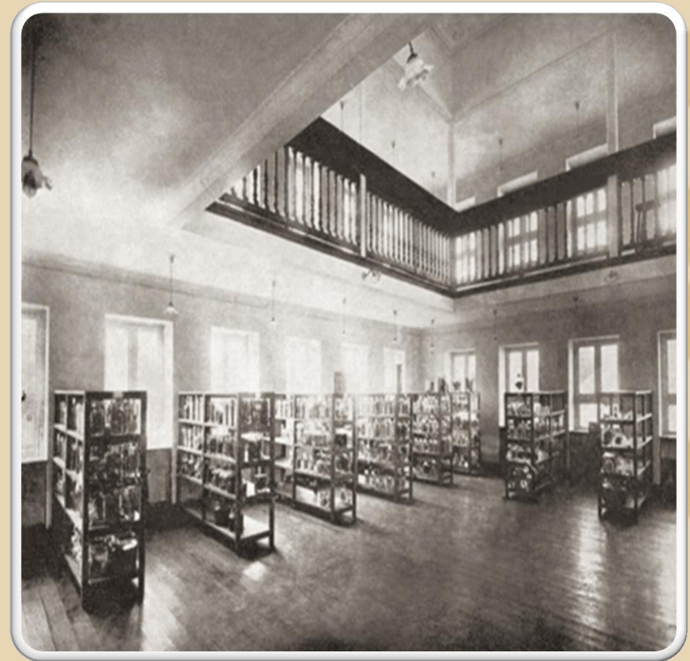
2 nd Pathological building พ.ศ. 2488
