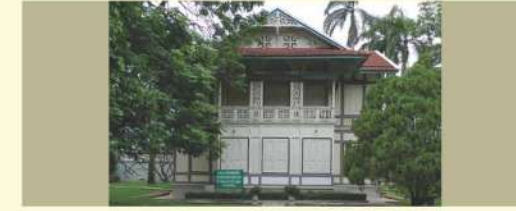
พระตำหนักสมเด็จพระศรีสวรินทิราบรมราชเทวี พระพันวัสสาอัยยิกาเจ้า พระราชวังบางปะอิน
